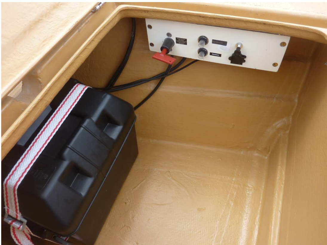
Batterie und Stromkreisverteilung im hinteren Stauraum
