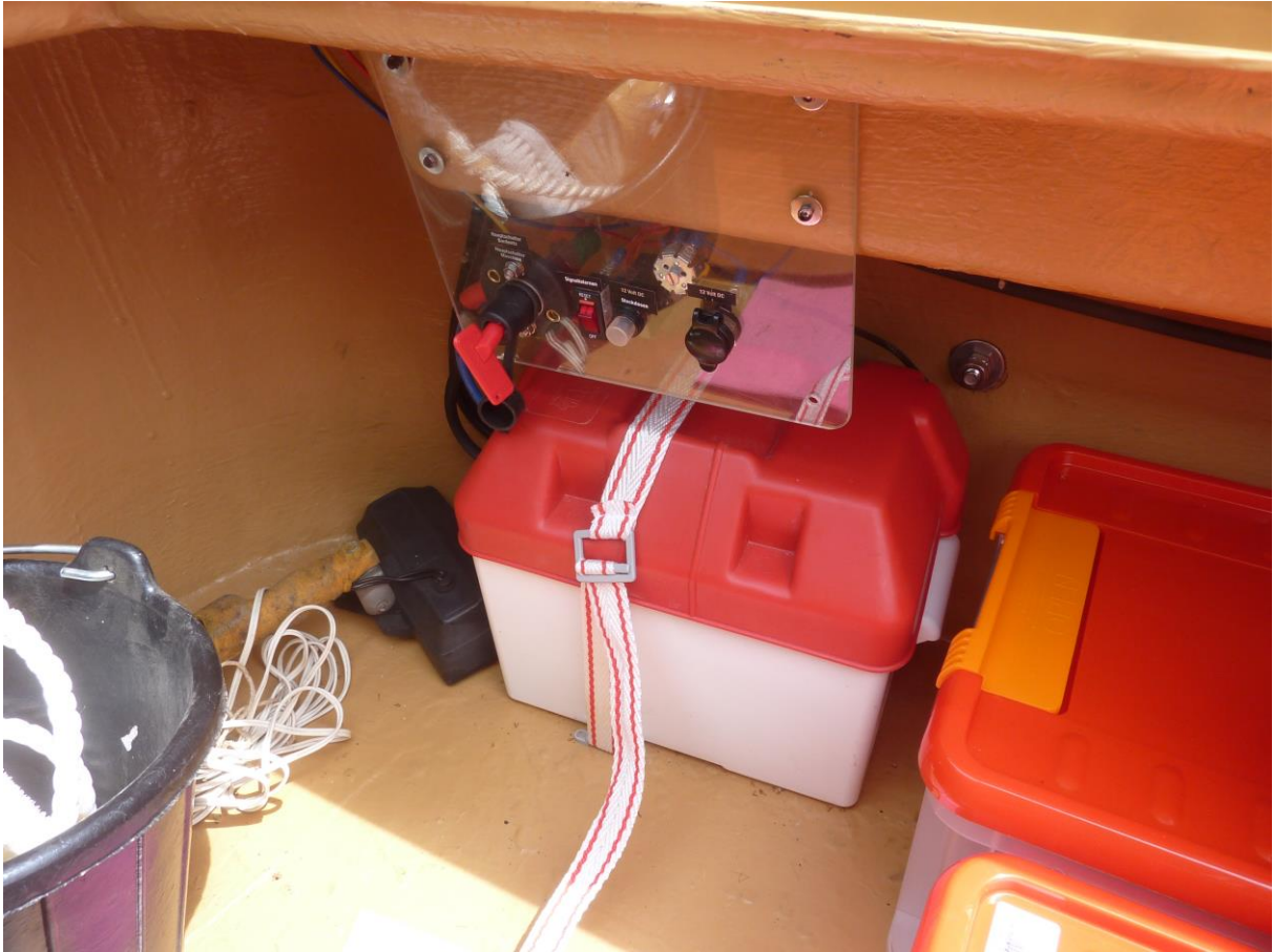
Batteriekasten mit Hauptschalter und Stromkreisverteilung im hinteren Staukasten
